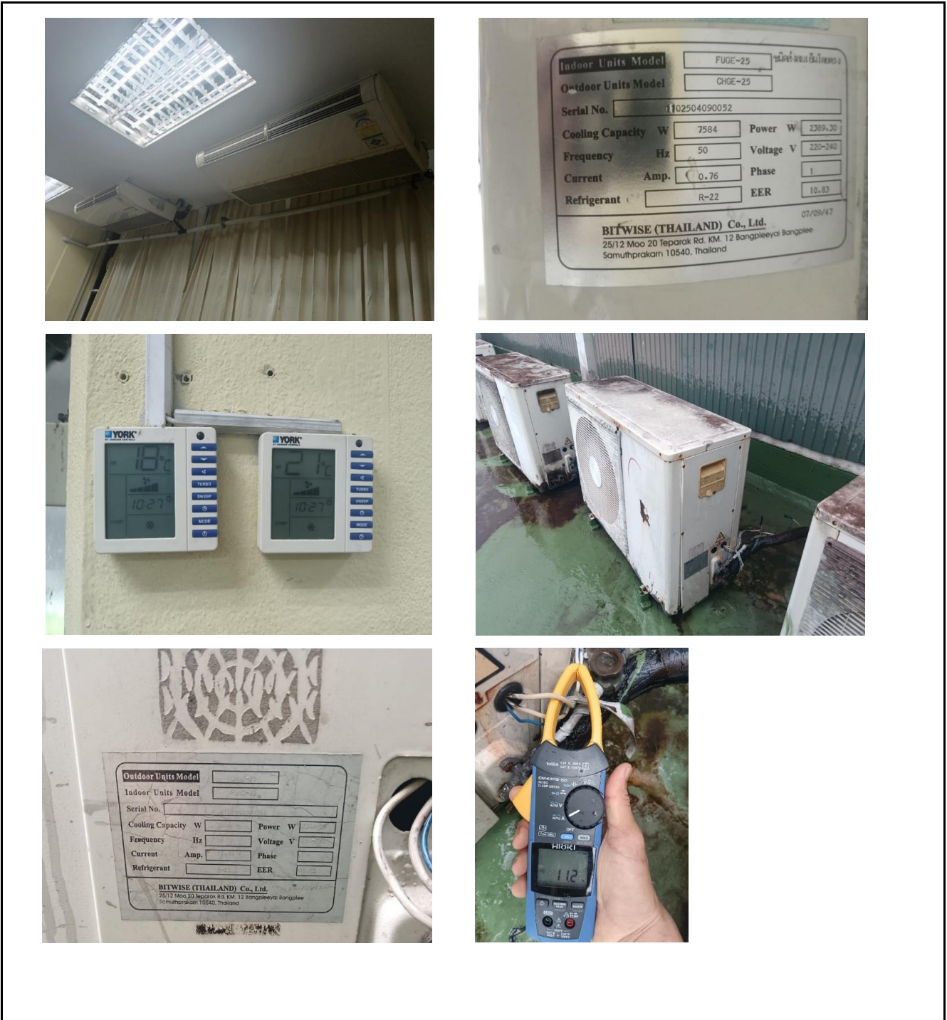
รูปที่ 5-1 ภาพก่อนดำเนินการปรับปรุง
