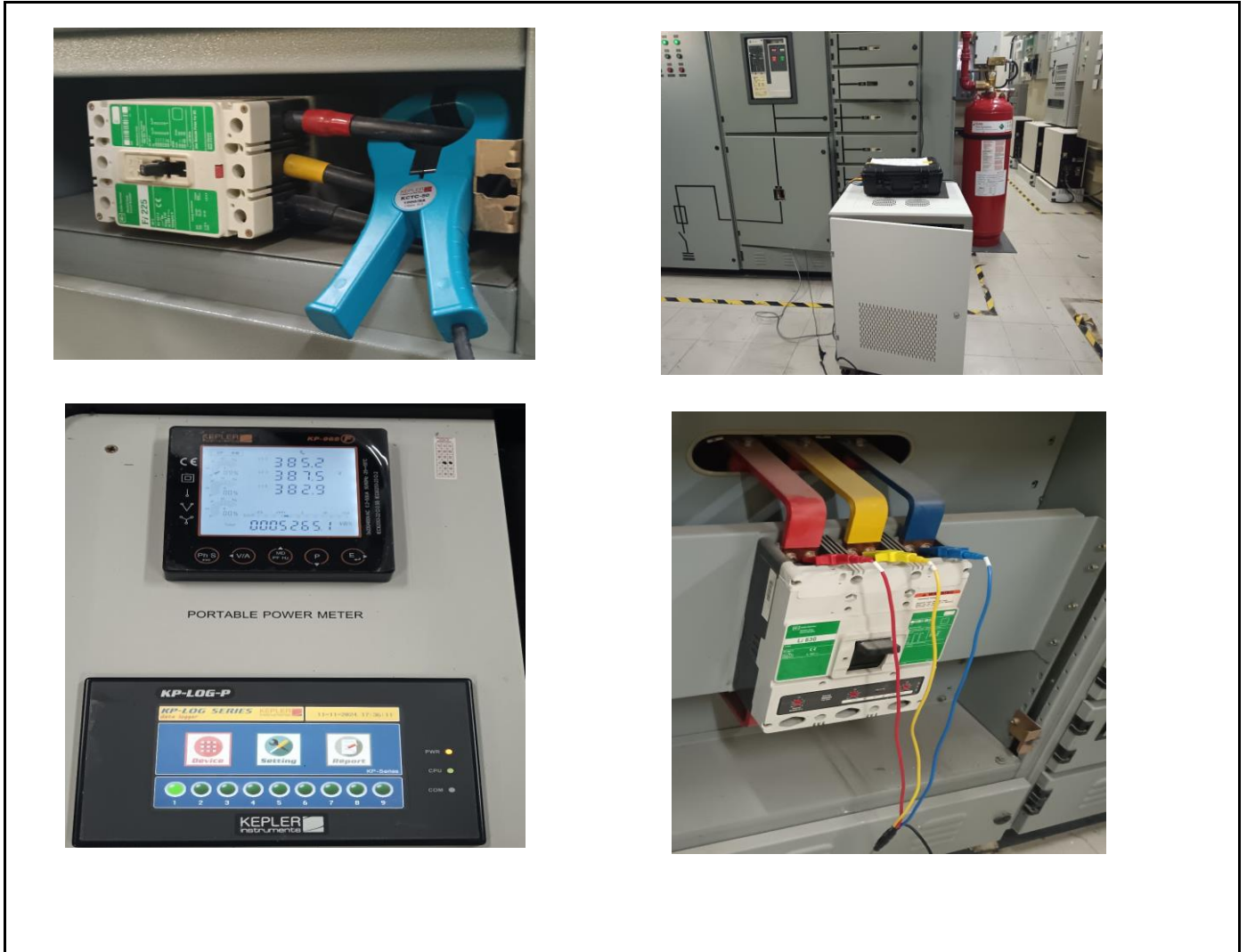
รูปที่ 6-1 หลังดำเนินการปรับปรุง
